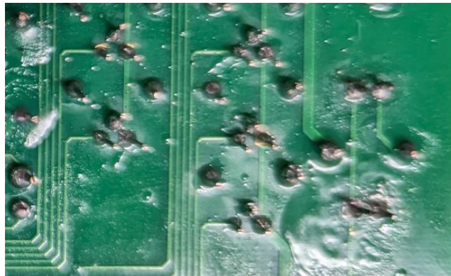
Platine nicht gesäubert, Kurzschlüsse möglich
